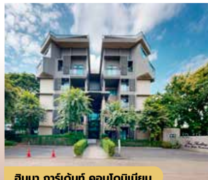
อิมมา การ์เด้นท์ คอนโดมิเนียม
